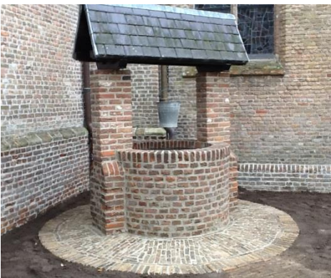
Nieuw voegwerk uitgevoerd door Johan van Oudheusden
